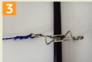
片方の輪に柵線を結び付けて下さい。
